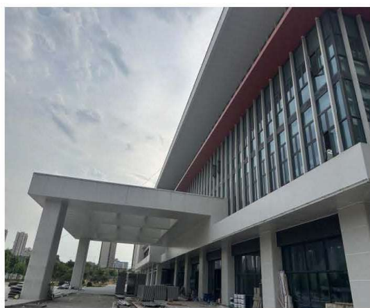
1 号楼（门诊）南侧院内道路
