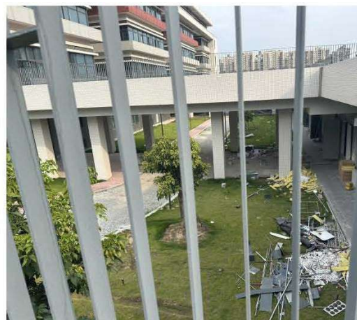
1 号楼（门诊）西侧院内道路
