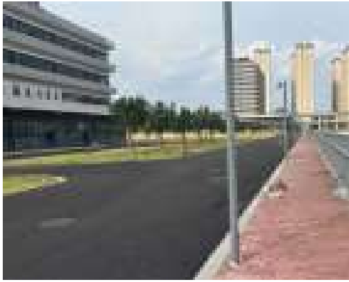
1 号楼（门诊）北侧院内道路
